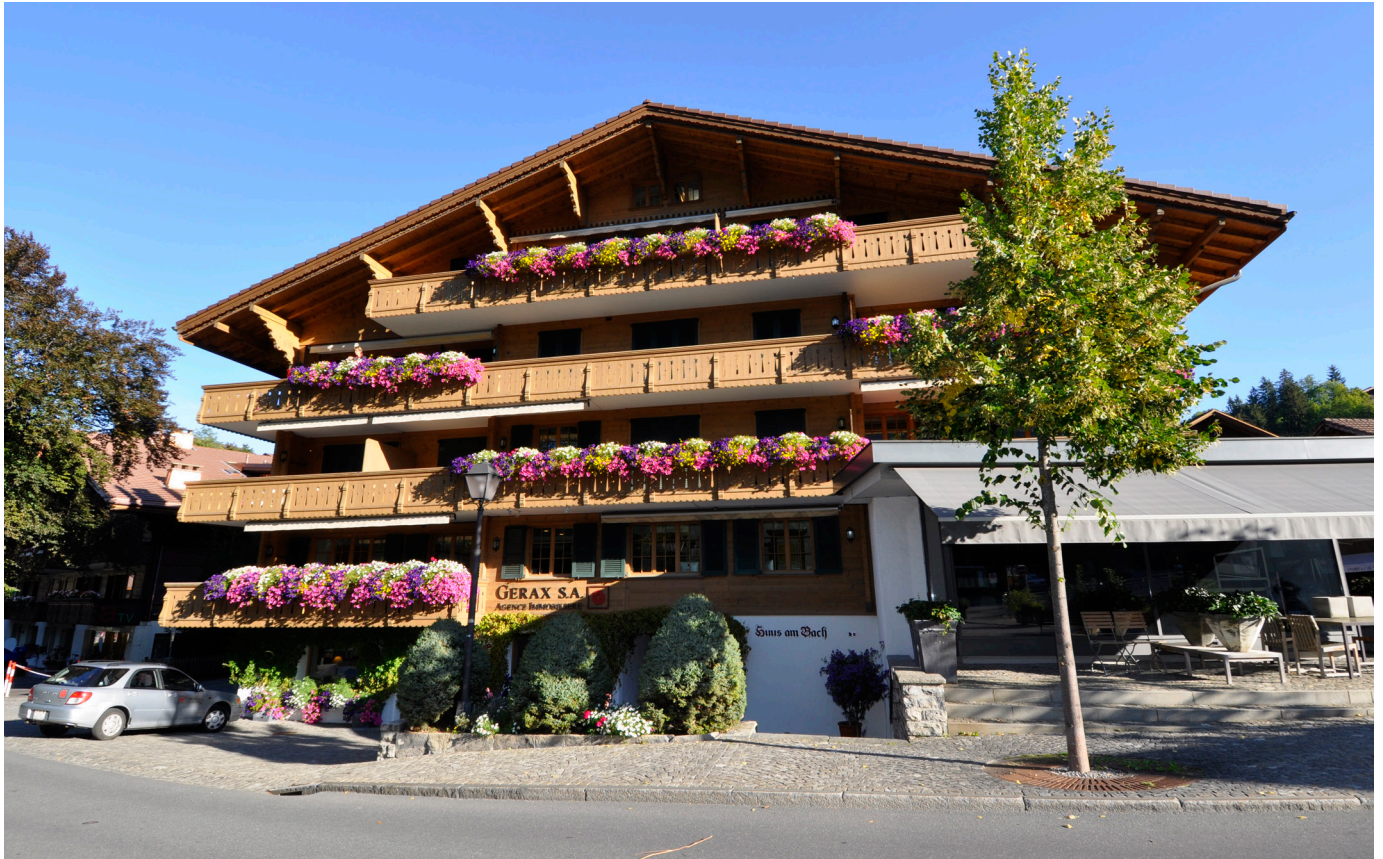
Das vor dem Abbruch gerettete «Huis am Bach», welches nun der Firmensitz von Gerax ist.
