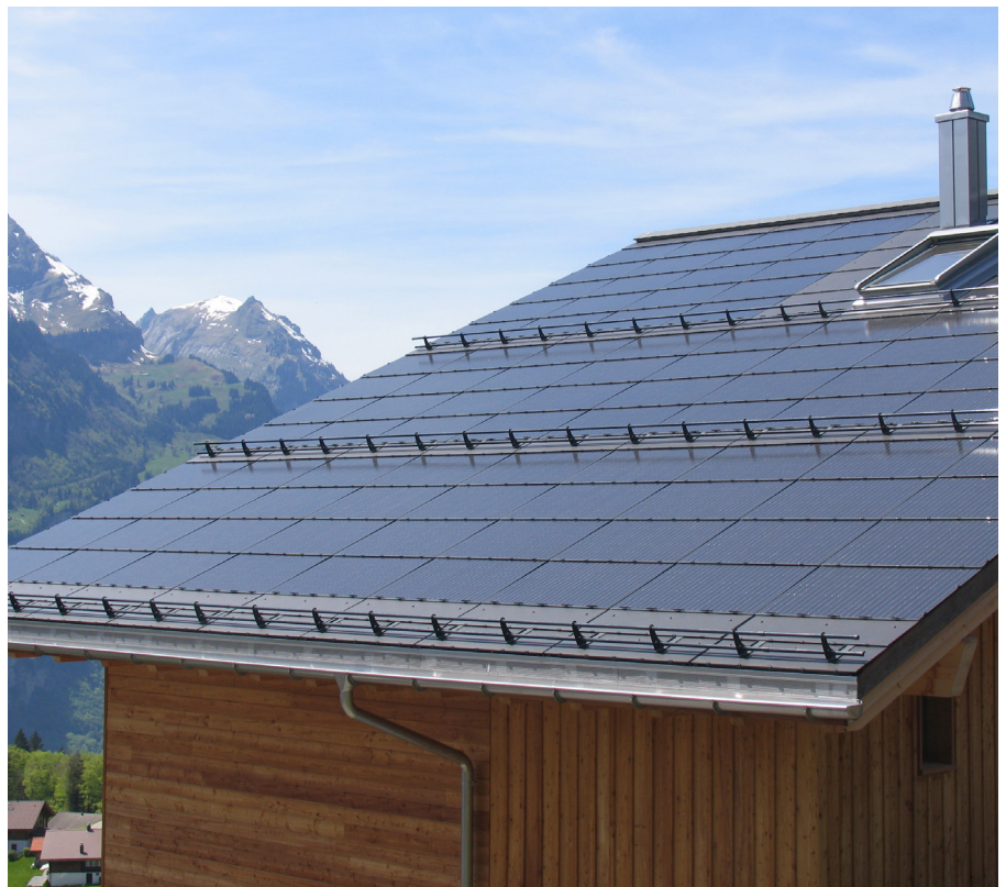
Solarschneefangsystem von Glaromat AG
